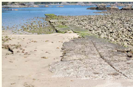
第112震洋隊間泊基地 滑台(南大隅町)
